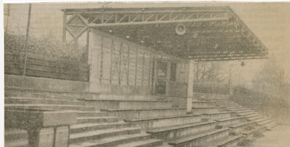
An die Stehtribüne des Max-Reger-Stadions werden zwei Geräteräume angebaut.
